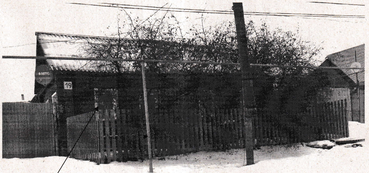
Фото 1. Жилой дом по адресу: Самарская область, Сергиевский район, с. Сергиевск, ул. Н.Краснова, д. 19
