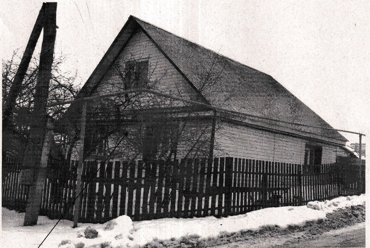
Фото 2. Жилой дом по адресу: Самарская область, Сергиевский район, с. Сергиевск, ул. Г.Михайловского, д. 1 (Пересечение ул. Н.Краснова и Г.Михайловского)
